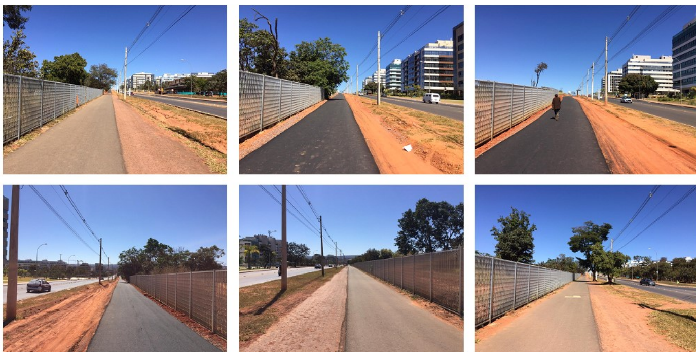
(Fotos da faixa lindeira à Via W7, mostrando a ciclovia)
