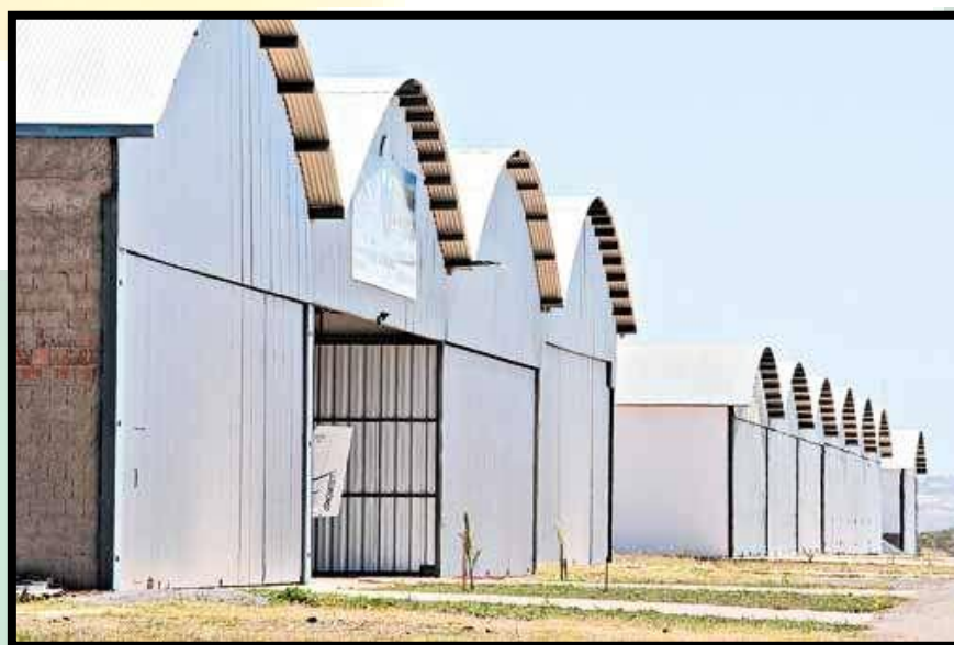
Figura 7 - Vista do conjunto de Hangares
