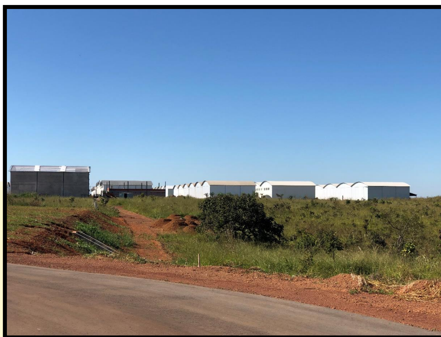
Figura 6 - Vista dos Hangares
