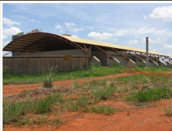
Foto 18 - Estação Furnas - Metrô DF.
