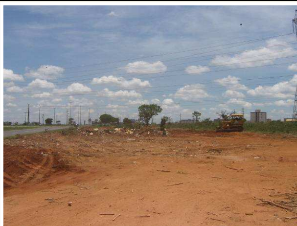
Foto 11 - Máquinas realizando trabalho de regularização do terreno com entulhos.
