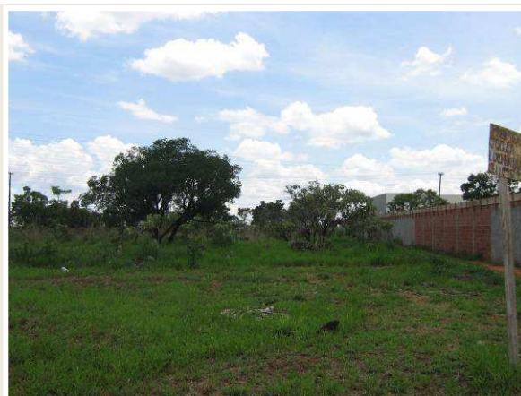
Foto 40 - Muro da Igreja.
