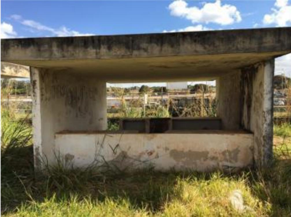
**Figura 19: Estrutura de apoio degradada.**
