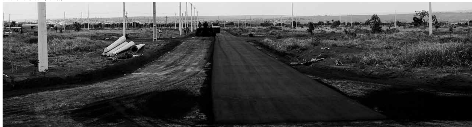
Obras de implantação do bairro: Terracap espera entregar a infraestrutura no início de 2010.
