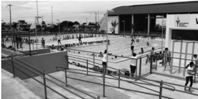
Vila Olímpica Rei Pelé, em Samambaia: obra concluída
