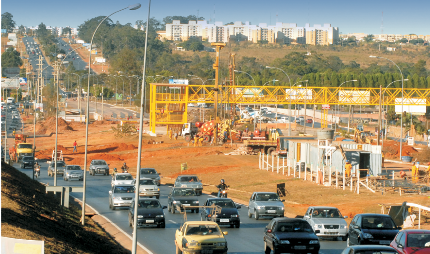
Obra do viaduto de acesso à Águas Claras, na EPTG
